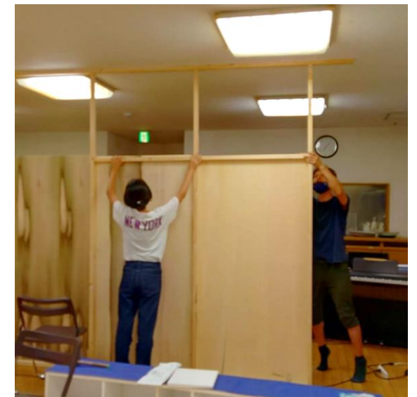
壁を作ってお部屋を仕切ります
